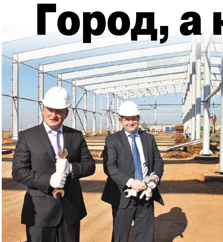
Строительство мусоросортировочного комплекса планируется завершить в конце декабря 2012 года.
